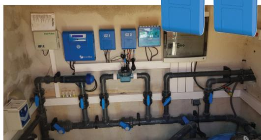
2 modules complémentaires, le module E21 à la connection Wi-Fi, donne les informations sur la température de l'air, de l'eau et sur le débit d'eau. Le module E22 se connecte au module E21 et informe sur le niveau de chlore, du pH et sur la pression de l'eau. WarmPac
