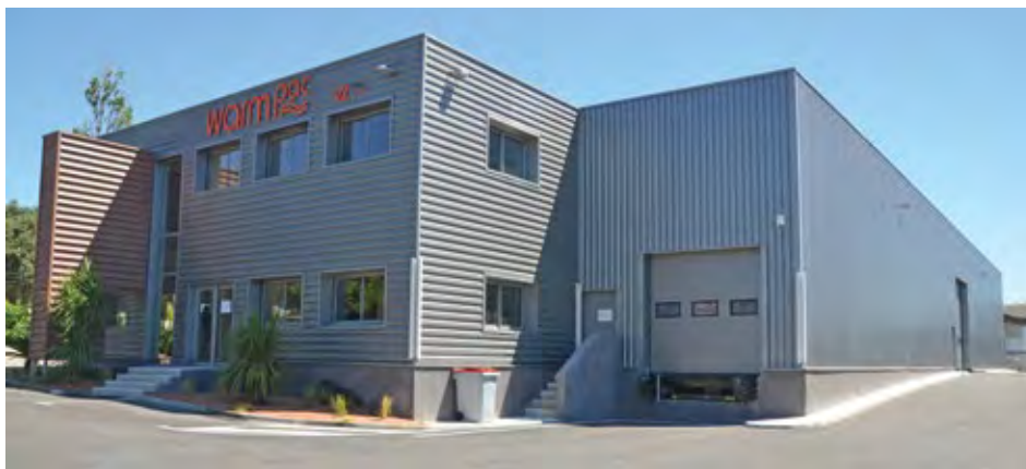
Le nouveau bâtiment à Vitrolles a été spécialement construit pour Warmpac. Outre son importante surface de stockage, il intègre un espace destiné au SAV et une salle de formation. Un film réalisé par un drone permet de découvrir le site sur le nouveau site internet www.warmpac.fr .
